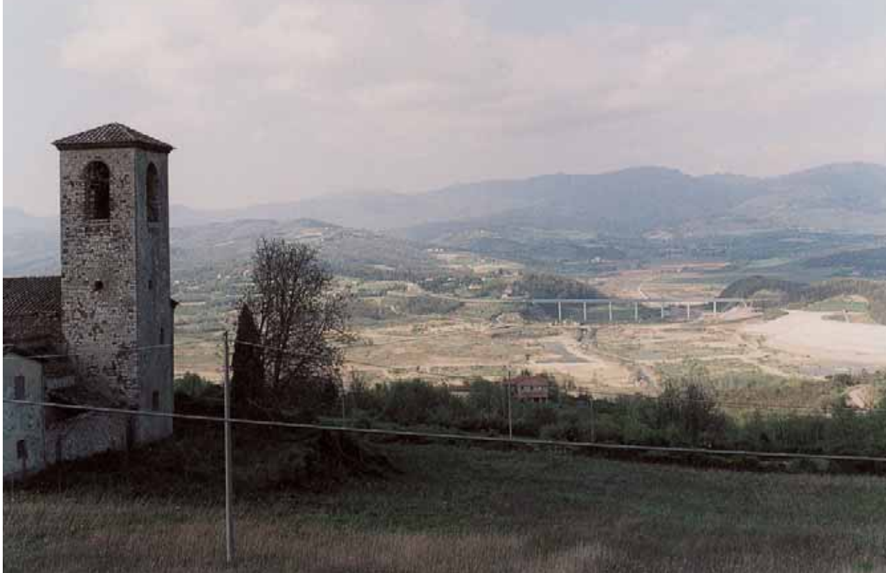
Diga del Bilancino-(aprile 1997): la diga del Bilancino e l'invaso vuoto fotografati da sud. In primo piano il campanile della chiesa di S. Giovanni in Petroio e, sullo sfondo, il nuovo viadotto della strada statale n. 65 (Firenze-Bologna) costruito per sostituire il precedente tracciato che sarebbe stato sommerso dalle acque del bacino.
