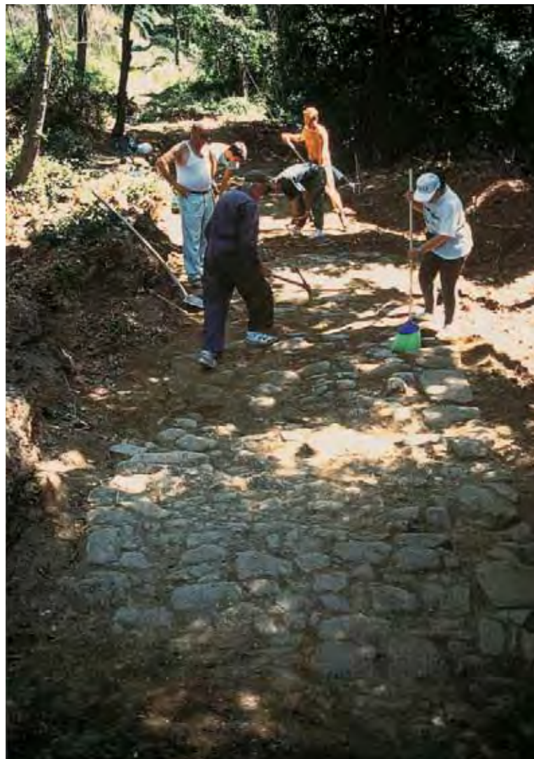
Monte Poggione (sito G/3-agosto 1996): una colorita squadra di scavatori volontari impegnati a riportare alla luce la strada. Si riconoscono da sinistra: Corrado Peli, Giampaolo Marchini, Giampietro Pizzo (di spalle), Giangiacomo Giovannini (chinato), Francesco Cappelli ed Alessandra Pizzo.
