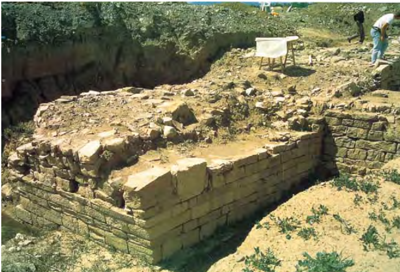
Fig. 173 - Ponte del Colombaiotto. Spalla sinistra (a nord): visione a valle della spalla con inizio di arcata e tre incassi al piano d'imposta.
