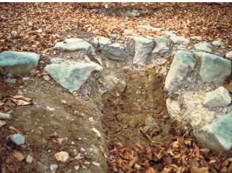
Monte Poggiaccio (sito C/3): lo scavo ha messo in evidenza la sezione della strada. Le pietre della pavimentazione, provenienti da cave vicine, si presentano con la parte più stretta rivolta verso il basso; in tal modo si assestavano sempre meglio sopra lo strato di glarium ed, a parità di superficie, opponevano maggiore resistenza alle spinte che ricevevano dall'alto.
