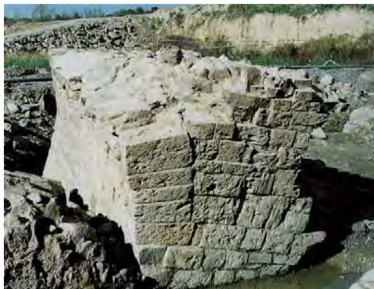
Fig. 176 - Ponte del Colombaiotto. Resti di filari di cunei ancora in opera sul fianco sinistro della pila V a valle (essi appartengono all'arcata vista a figura 175).
