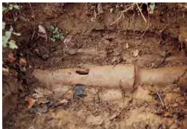
La Faggeta: acquedotto costruito con tubi in cotto ad innesto, che portava l'acqua dal m. Bastione all'edificio della Faggeta, rinvenuto alla profondità di 50 cm, risalente probabilmente al 1300-1400.
