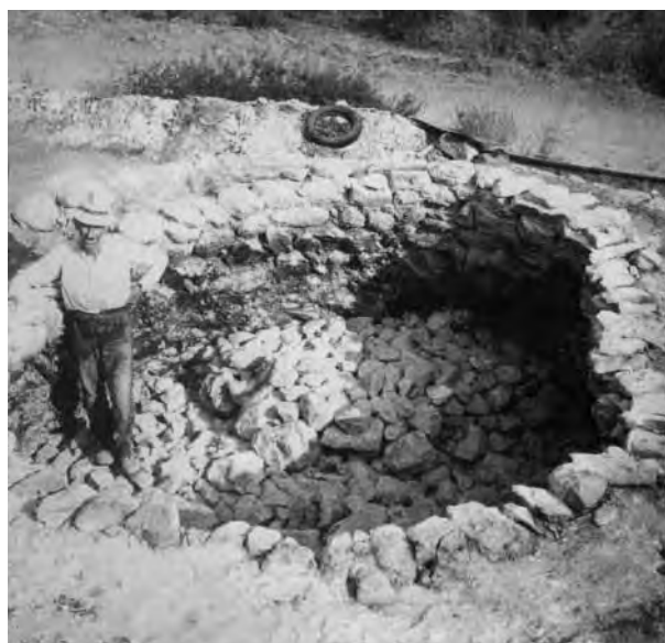
Il completamento del riempimento di un forno in Grecia vicino ad Epidauro. La procedura seguita è la stessa tramandata nei secoli ed è evidente la somiglianza con la fornace riportata alla luce ancora piena alla Piana degli Ossi. (Tratto da Jean Pierre Adam: "L'arte di costruire presso i Romani - Materiali e tecniche". Ed. Longanesi e C., Milano, 1984).
