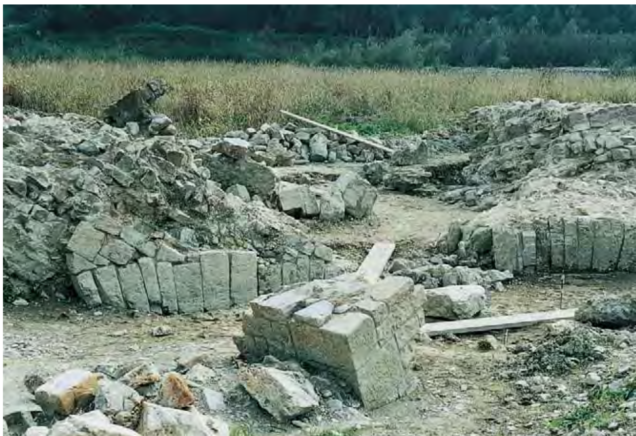
Fig. 175 - Ponte del Colombaiotto. Arcata crollata tra la IV e V pila da sinistra.
