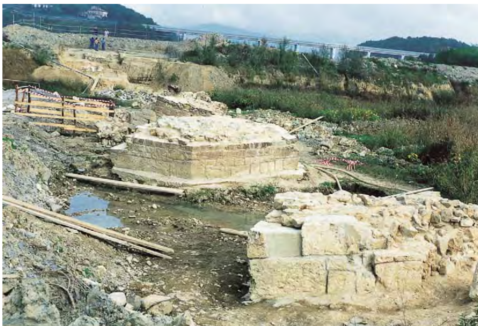
Fig. 170 - Ponte del Colombaiotto. Visione generale del ponte dalla probabile pila VII verso la spalla sinistra superstite.
