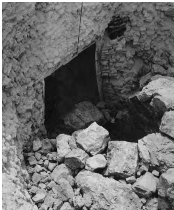
Una fornace in Campania: nella fase di riempimento del forno la camera di riscaldamento era costruita con blocchi di calcare più voluminosi. (tratto da Jean Pierre Adam: "L'arte di costruire presso i Romani - materiale e tecniche". Ed. Longanesi e C., Milano, 1984).
