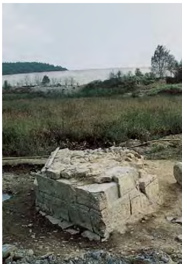
Fig. 179 - Ponte del Colombaiotto. La probabile VII pila vista a monte.
