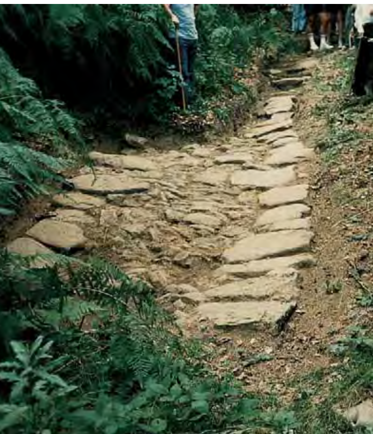
Monte Bastione (sito A/4-direzione sud): in questo tratto anche il bordo a valle del lastricato (lato destro) è costruito con grossi blocchi di arenaria posati orizzontalmente.
