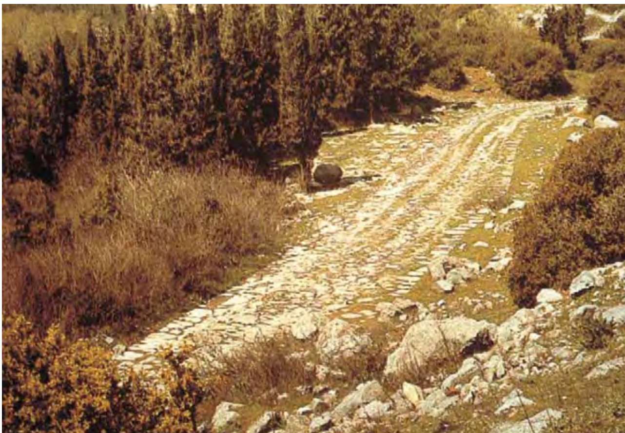
Un importante tratto della via consolare Egnatia in Macedonia costruita dai Romani nel I sec. a.C., che collegava Durazzo con Salonicco. Anche in questo caso è evidente l'impiego di materiale locale per la costruzione della pavimentazione stradale.
