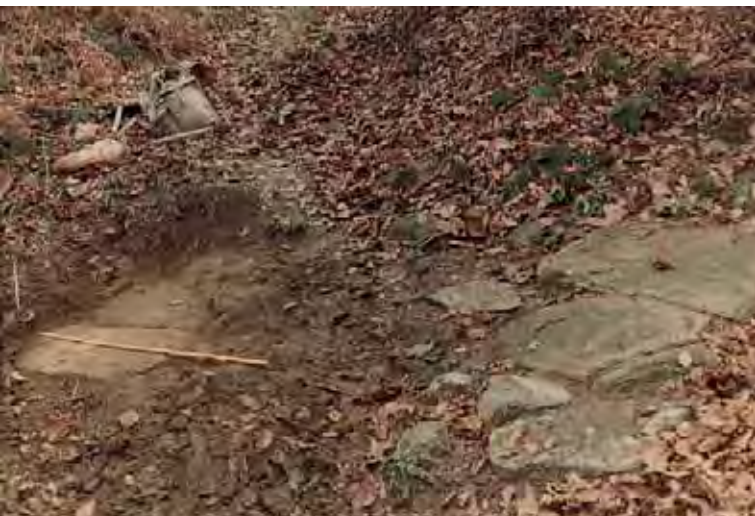
Monte Bastione (sito A/3): l'unico tratto non deformato dalla frana nel sito A/3. Grosse pietre di arenaria riemergono dal bosco definendo i due bordi della strada. Il metro appoggiato sul lastricato dà l'idea visiva della larghezza dei basoli e della carreggiata stradale.
