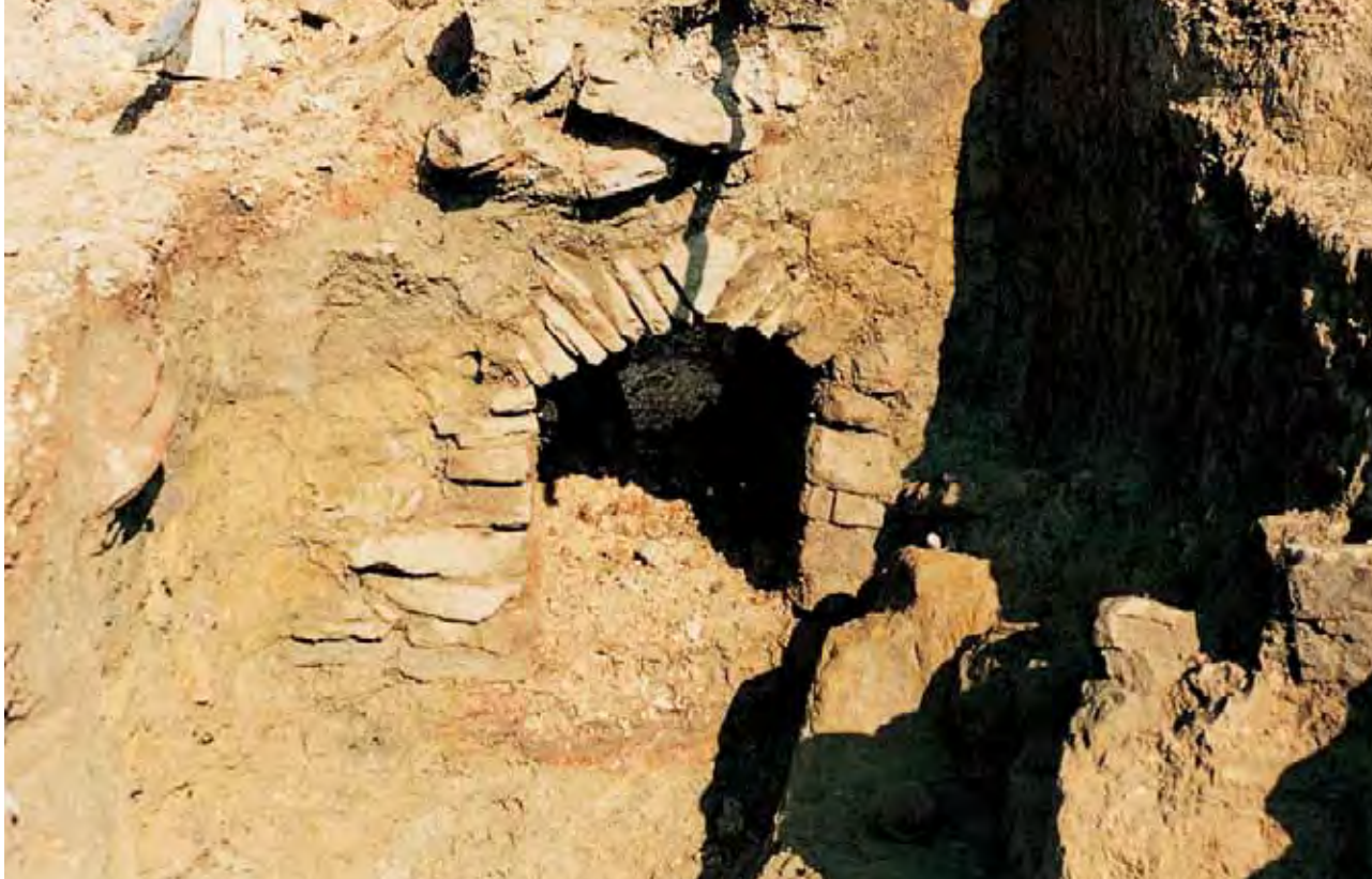
Piana degli Ossi (luglio 1989): il lato esterno del corridoio di accesso alla fornace, posto alla sua base, attraverso il quale veniva introdotta la legna per alimentare il fuoco.
