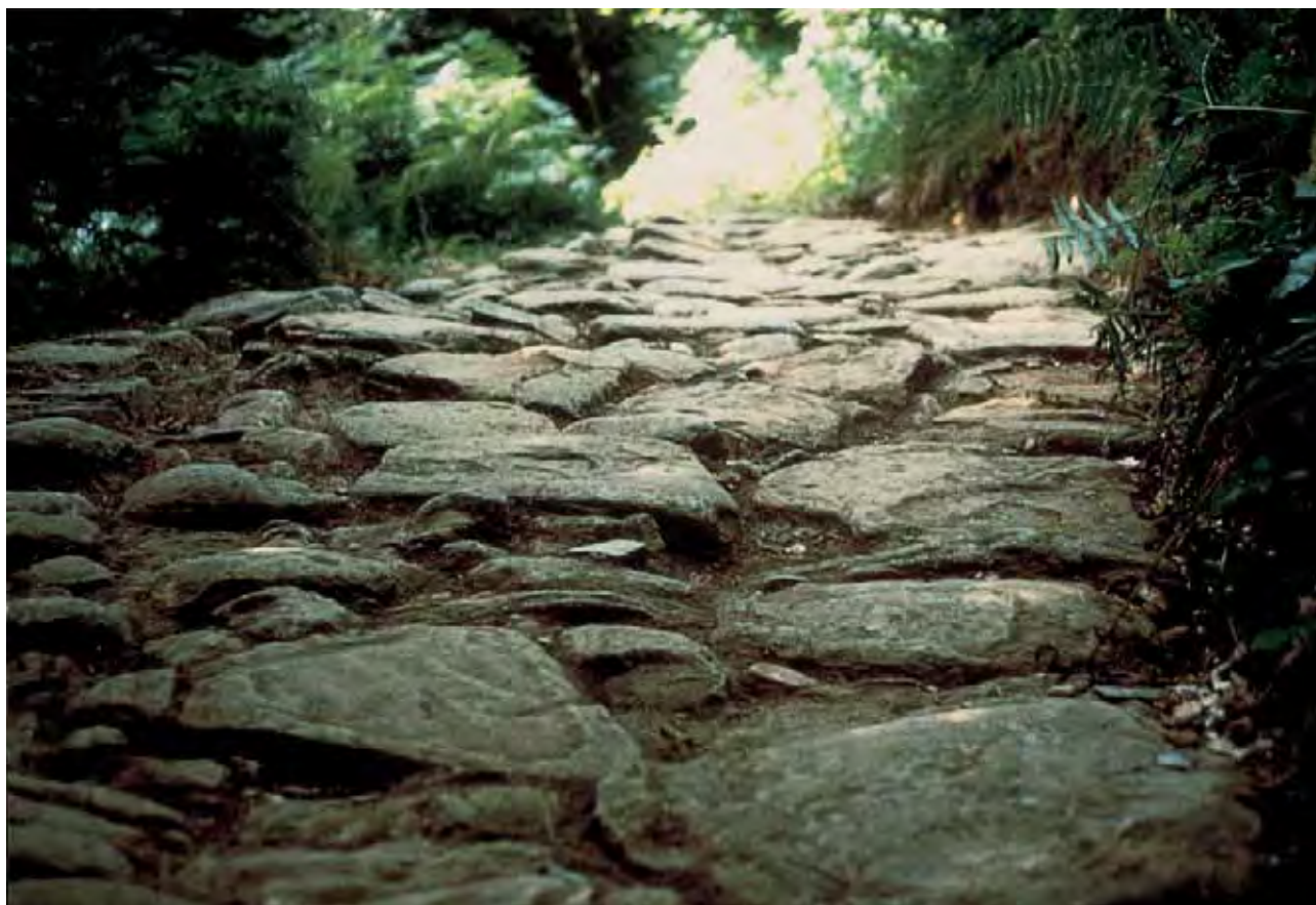
Monte Bastione (sito A/1-direzione nord): un'immagine ravvicinata della pavimentazione.
