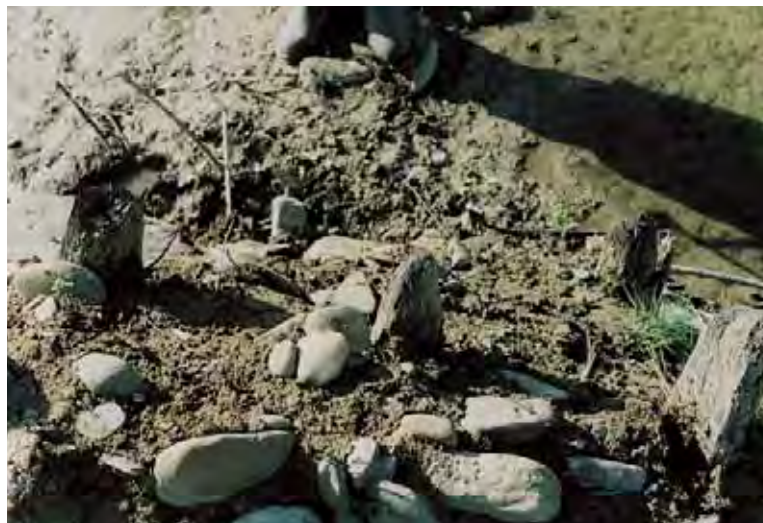
Fig. 174 - Ponte del Colombaiotto. Resti della probabile II pila con pali infissi nel nucleo.
