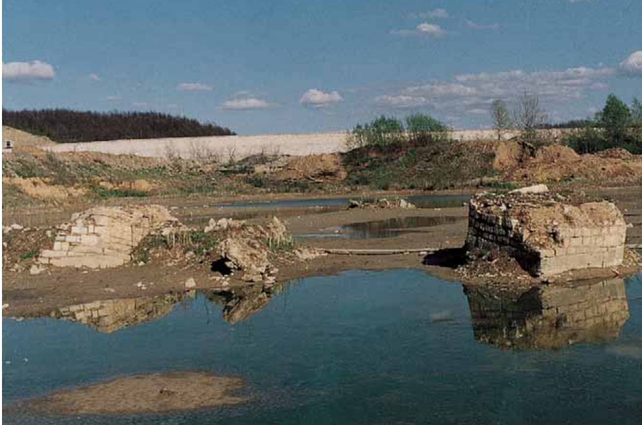
Ponte di Colombaiotto (zona archeologica "H"- aprile 1994): i resti di due pile del ponte emersi nel corso dei lavori di scavo per la costruzione della diga del Bilancino (sullo sfondo) così come ci sono apparsi il giorno del nostro primo sopralluogo.
