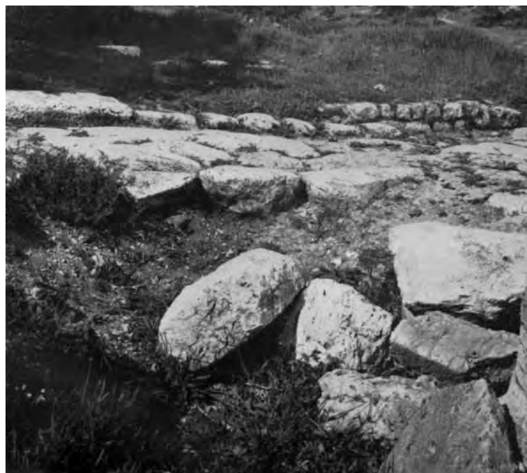
Resti della via Flaminia a Carsulae vicino a S. Gemini (prov. di Terni) (da “Le strade romane in Italia” di Daniele Sterpos, “Quaderni di Autostrade”, pag. 31). Si noti la forma piramidale delle pietre.
