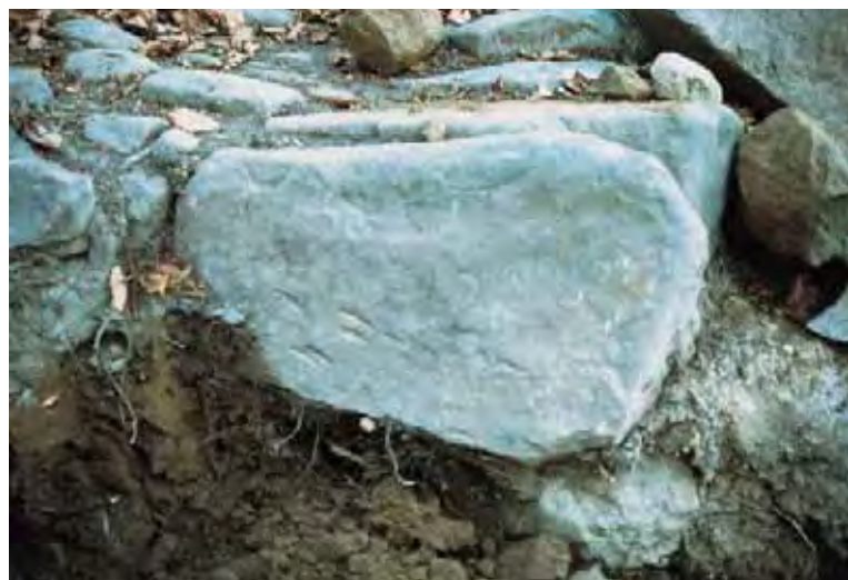
Monte Poggiaccio (sito C/3): la sezione della pavimentazione ha evidenziato che le pietre sottili sono state posate in verticale. Su questa pietra si notano ancora i segni delle scalpellature fatte al momento della posa. I piccoli segni bianchi sono stati fatti da noi.
