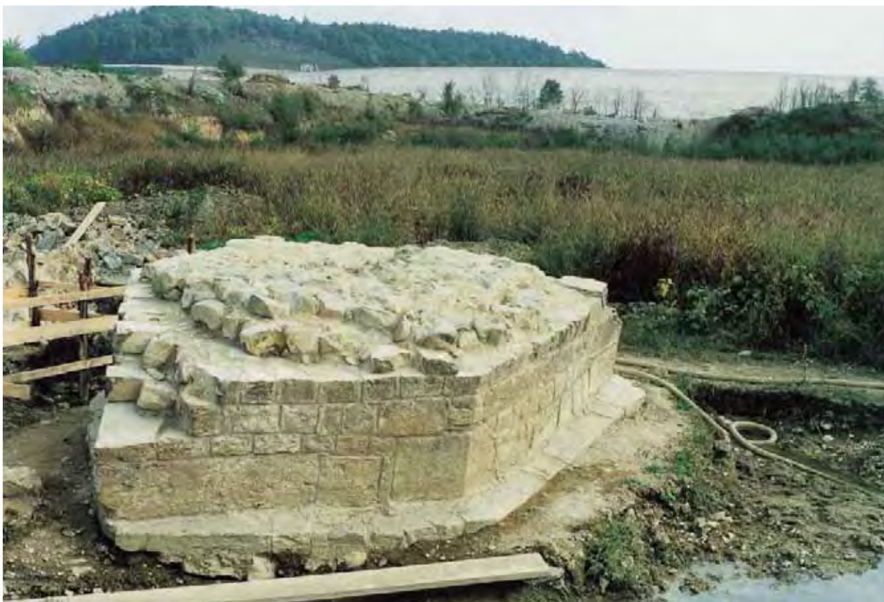
Fig. 178 - Ponte del Colombaiotto. L'imponente rostro (avambecco) a monte della VI pila.
