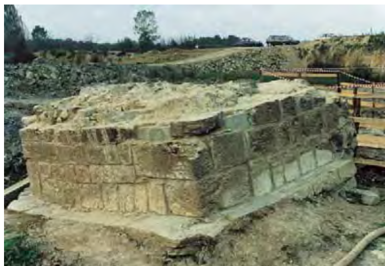
Fig. 177 - Ponte del Colombaiotto. La probabile VI pila, vista da sud, sullo zoccolo di fondazione.
