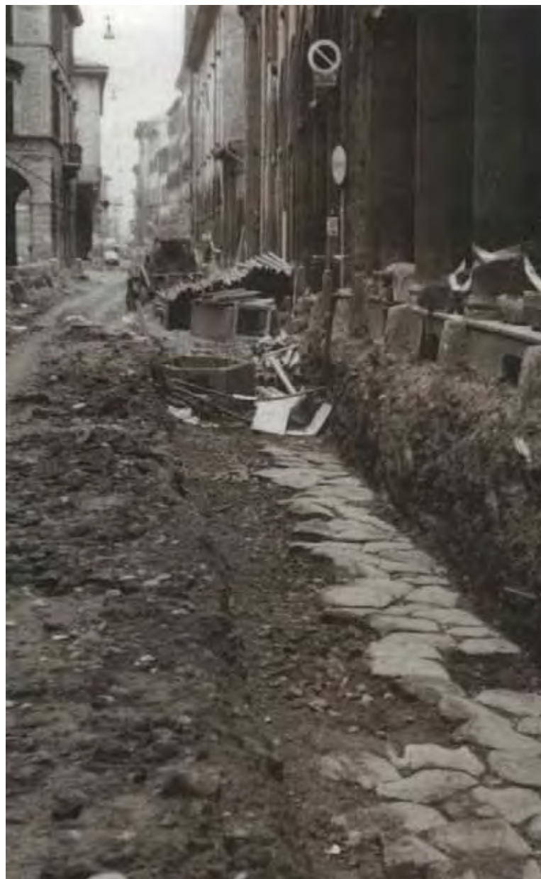
La pavimentazione di Bologna romana riemersa all’inizio di Strada Maggiore in occasione di lavori di scavo per la posa di condutture sotterranee (novembre 1981).
